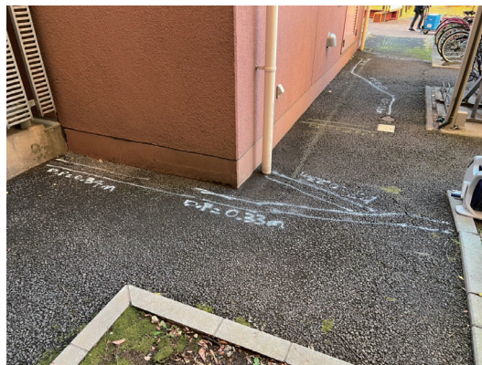
壁際雨水管探索・管径測定
