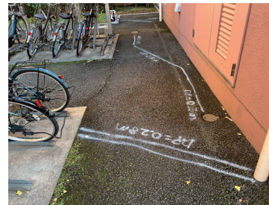
上水道管 VP13 壁際検知
