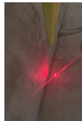
上水道管 VP13 壁際検知
