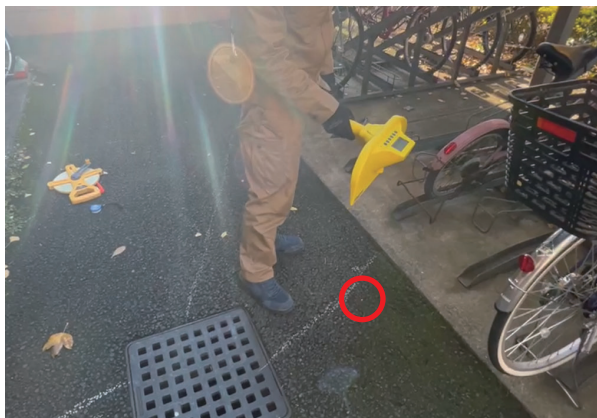
雨水管側面の検知
